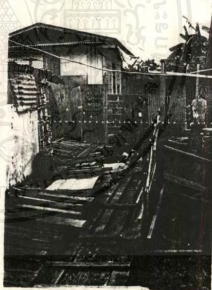
ลักษณะทางเดินภายในเชื่อมแต่ละบ้าน เป็นทางเดินไม้ พื้นที่บางส่วนยังคงเป็นน้ำครำ มีการเว้น Space ของแต่ละบ้าน ไม่ได้ยู่ชิดติดกัน โดยมีเส้นทางเดินเท้าเล็กๆ เลาะไปตาม Space เหล่านั้น
