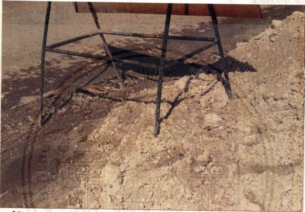
ภาพที่ 3 การติดตั้งขี้าย
