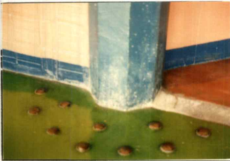
บริเวณใกล้เสามีปูมเพื่อป้องกันอันตราย จากการเดินชน
