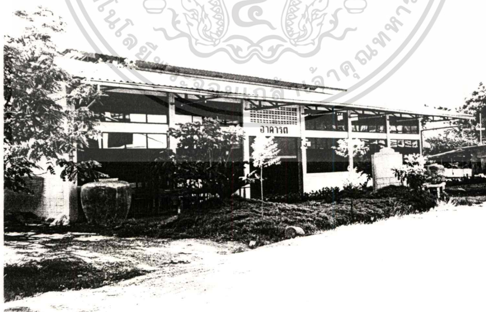
ภาพที่ 1.4 แสดงแบบรูปอาคารฝึกงาน แบบ บลค.
