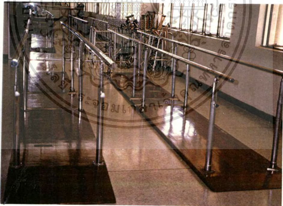
รูปที่ 4.79 แสดง ราวฝักขึ้นและเดิน (Parallel Ramp) ขนาด 0.90*3.00 เมตร
