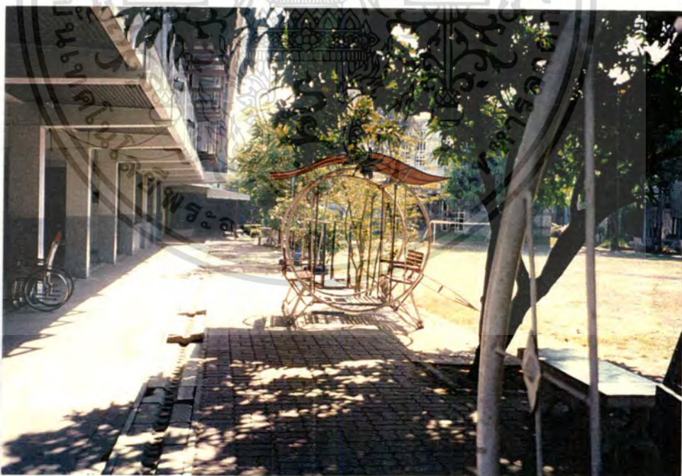
รูปที่ 4.143 แสดง ทางเดินเชื่อมระหว่างอาคาร ไม่มีหลังคาคลุม
