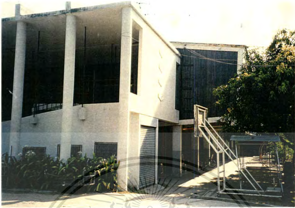
รูปที่ 4.4 แสดง อาคารทอนอนชาย 2 ชั้น
