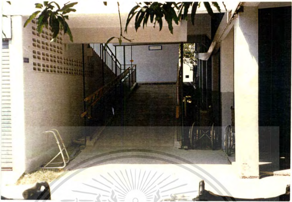
รูปที่ 4.119 แสดง ทางลาดภายในอาคารหอนอนชาย
