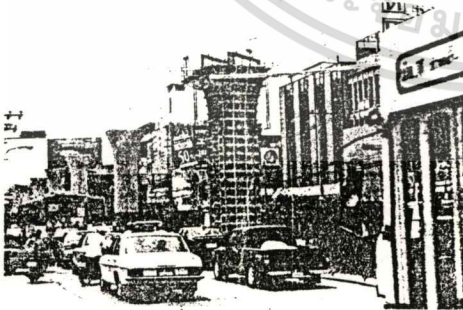
สภาพการก่อสร้างโครงการรถไฟฟ้า
