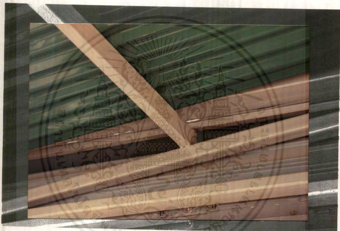
ภาพที่ 5 แสดงปัญหาของวัสดุหลังคาและการบิดต่อ
