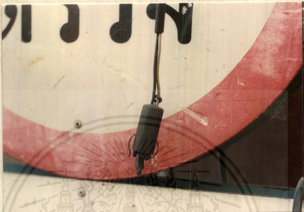
ภาพที่ 5 แสดงลักษณะการเดินสายไฟที่ไม่เรียบร้อย
