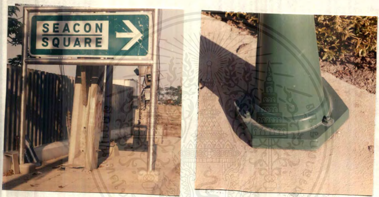
ภาพที่ 115 แสดงฐานคอนกรีตในลักษณะการยึดโครงสร้าง
