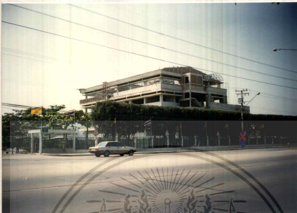
รูปที่ 3. อาคารศูนย์อบรมการไปรษณีย์แห่งเอเชียและแปซิฟิก ซึ่งกำลังดำเนินการก่อสร้าง
