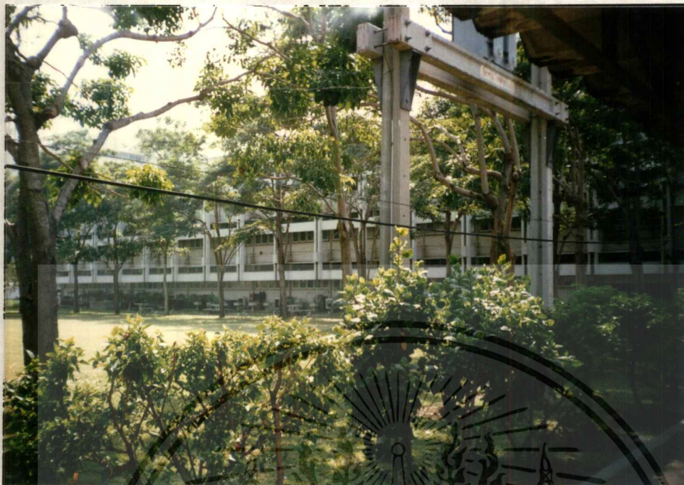
รูปที่ 5. อาคารองค์การโทรคมนาคมแห่งเอเชีย และแปซิฟิก
