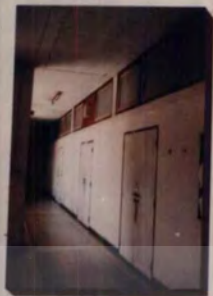
corridor ใน ๘ ห้อง LAB ชั้น ๓ อาคารภาษา
