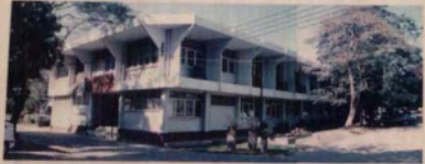
อาคาร ๑๐ คณะศึกษาศาสตร์ ประกอบด้วย แล่นรถและลานจอดรถบน และล่างพร้อมลิฟต์ (ชั้นฐาน) ภาพอาคารประกอบด้วย - ห้องเรียน - ห้องปฏิบัติการ - ห้องสมุดภาคพื้น - ห้องเรียนภาษาต่าง - ห้องกีฬา - ห้องน้ำ (ชั้น)
