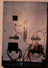
มีการซ่อมระบบการทำความเย็นปรับอากาศ
