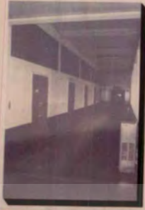
Corridor ทางบริเวณสี่ ชั้น 1 บริเวณแผนกช่างเครื่องปรับอากาศ
