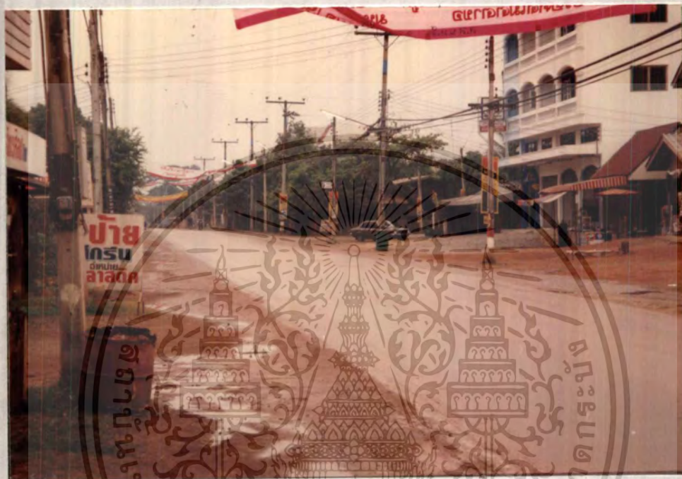
ภาพที่ 4.5 แสดงสภาพการจราจรด้านหน้าโครงการ บนถนนพหลโยธิน มุ่งสู่ จังหวัด เชียงราย
