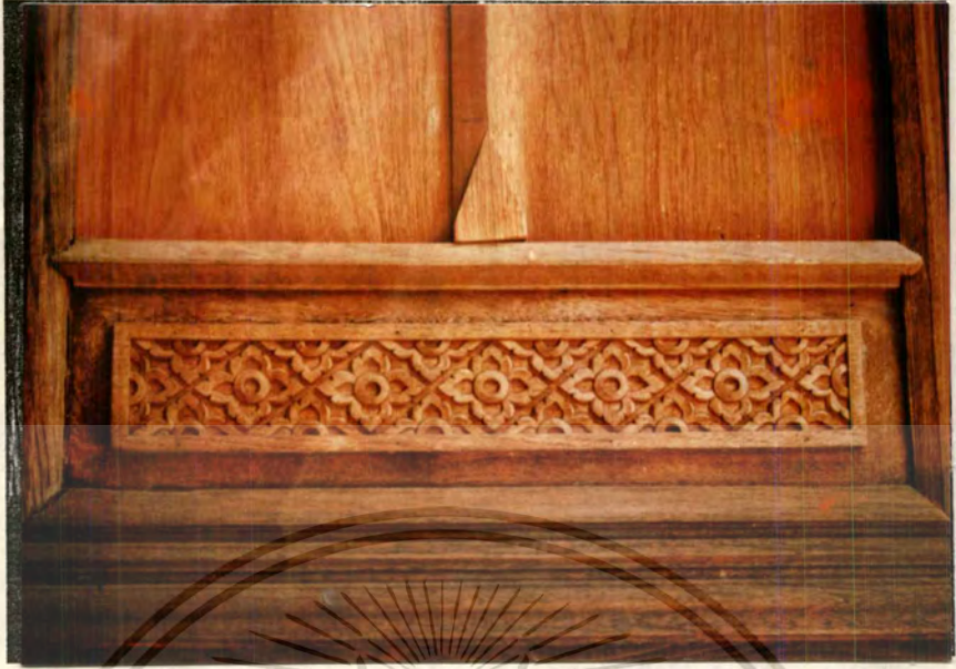
รูปที่ 41 หย่อง ส่วนประกอบของหน้าต่างที่ช่วยให้หน้าต่างสูงขึ้นจากพื้น
