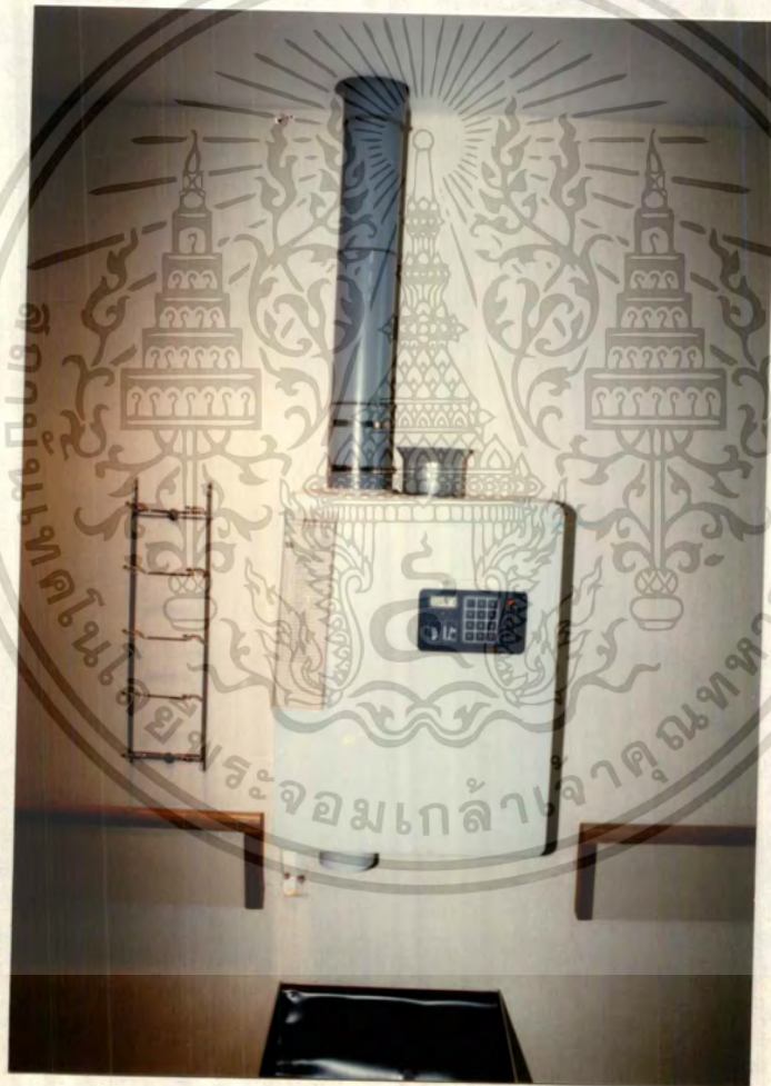
ภาพที่ 4.17 แสดงลักษณะของท่อส่งเอกสาร DENEMATIC TUBE
