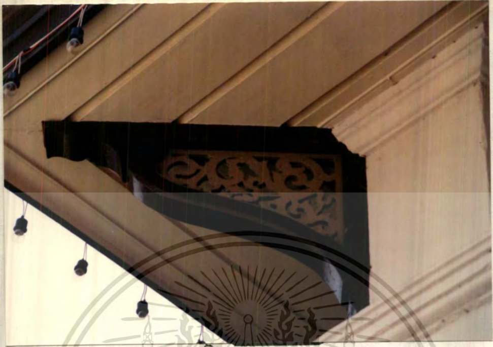
ภาพที่ 4.51 แสดงรายละเอียดของลวดลายเสาค้ำยัน
