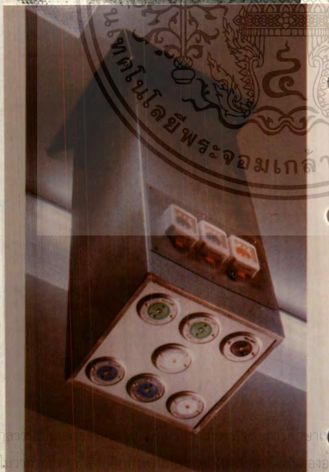
ภาพที่ 4.18 แสดงหัวจ่ายแก๊สแบบ เสา COLUMN
