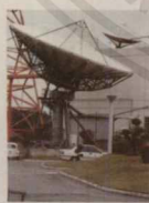
รูปถ่ายของอาคาร ที่ติดตั้งจานดาวเทียม บนหลังคา
