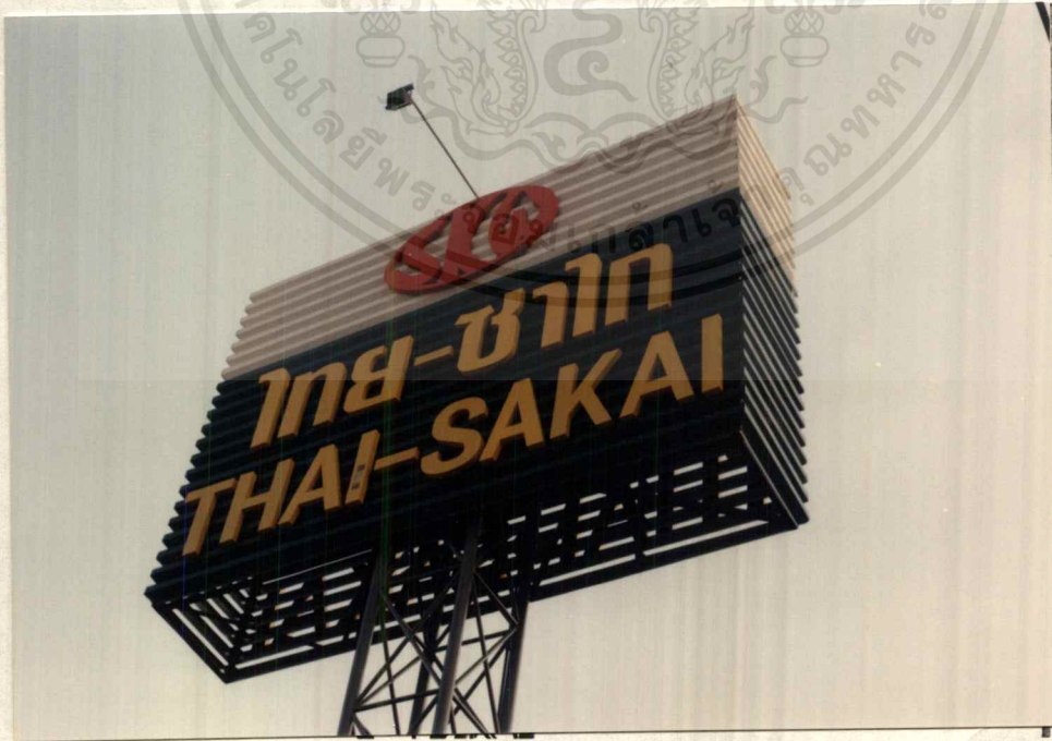
รูปที่ 12 แสดงโครงสร้างภายในป้าย มีลักษณะเป็นโครงเหล็ก
