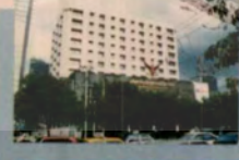
อาคารเรียนคอมพิวเตอร์ ชั้นเรียนคอมพิวเตอร์
