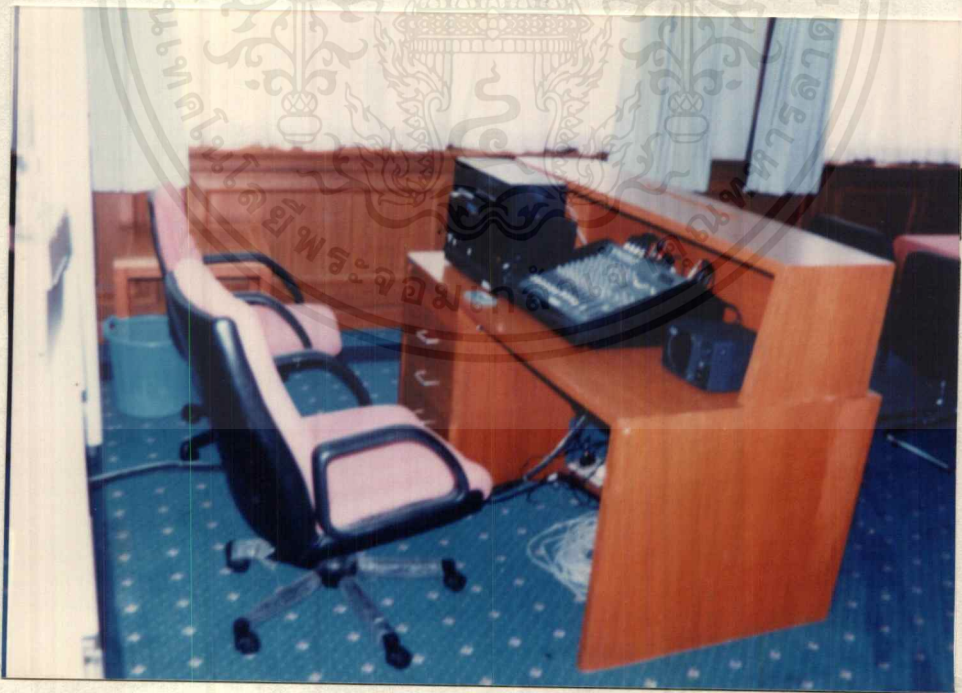
ภาพแสดง ส่วนควบคุมระบบแสง, เสียงภายในห้องประชุม
