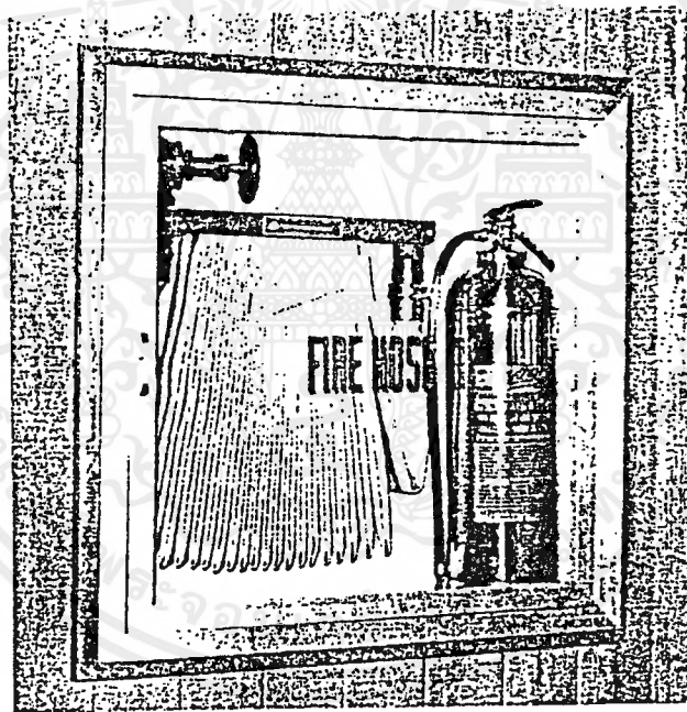
ตู้ดับเพลิง ชนิดใช้น้ำเป็นตัวดับไฟ พร้อมถังดับเพลิงเคลื่อนย
