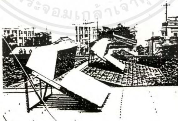
(ค) ตัวอย่างเครื่องทำน้ำร้อนพลังแสงอาทิตย์แบบหมุนเวียนขณะติดตั้งบนหลังคาบ้าน
