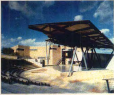
โครงสร้างส่วนหลังคาเวที
