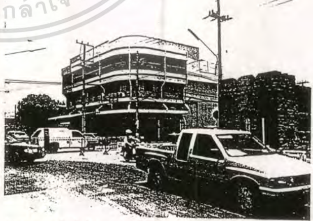
5 อาคารพาณิชย์บริเวณประตูสวนปรุง
