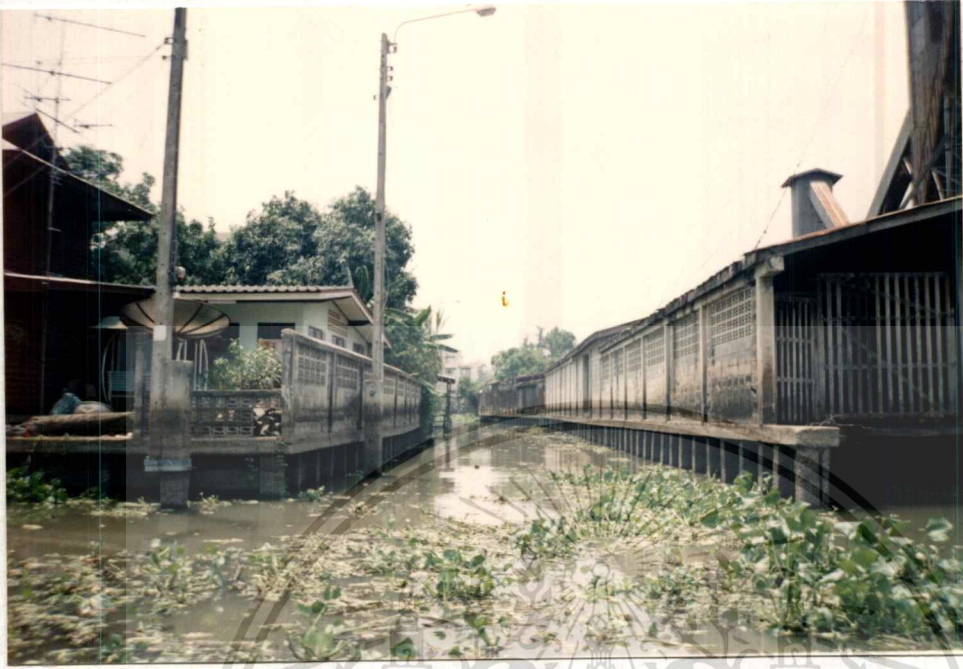
ภาพที่ 4 แสดงคลองในพื้นที่ศึกษาที่โครงสร้างตลิ่ง 2 ข้างเป็นคอนกรีต
