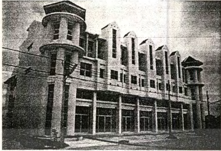
- แบบทาวนิโฮมออฟฟิศ เป็นอาคารเรียงติดกันเป็นแถว ไม่มีบริเวณ มีขนาดเล็กหน้ากว้าง 4 - 6 เมตร อาคารมีความสูงตั้งแต่ 2 - 5 ชั้น
