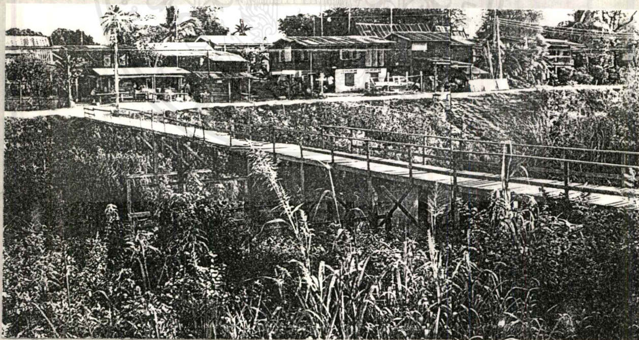
สะพานไม้ อ.กะปาง จ. นครศรีธรรมราช
