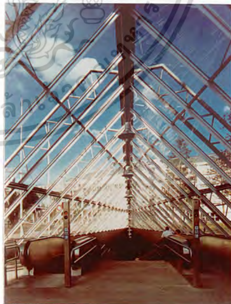
SPACE ภายในและโครงสร้างหลังคา
