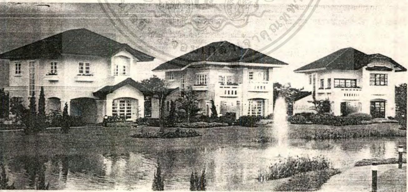
ภาพแสดงอาคารขนาดความสูง 1-2 ชั้น ซึ่งถือเป็นอาคารประเภทชุมชนเมืองระดับความหนาแน่นต่ำ ซึ่งใช้พื้นที่บริเวณถนนสุขุมวิท 3 และช่วงถนนสุวิทวงศ์ เป็น Training Area ไม่มีการเดินเตาะโผล่ ออกกึ่งตามมีเหตุแบบถ้อยคำ และตยอ ขององเงาของเอกสารทุกครั้งที่มีการนำไปใช้
