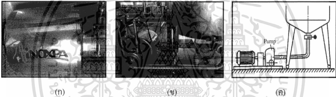
ภาพที่ 3.25 ลักษณะการติดตั้งบ้มี (ก) มีฝาครอบและครอบตัวบ้มี (ข) ติดตั้งบ้มีใต้ถังซึ่งห่างจากขอบถัง 15 เซนติเมตร สูงจากพื้น 3 เซนติเมตร (ค) ลักษณะการติดตั้งบ้มีที่ถูกสุขลักษณะ
