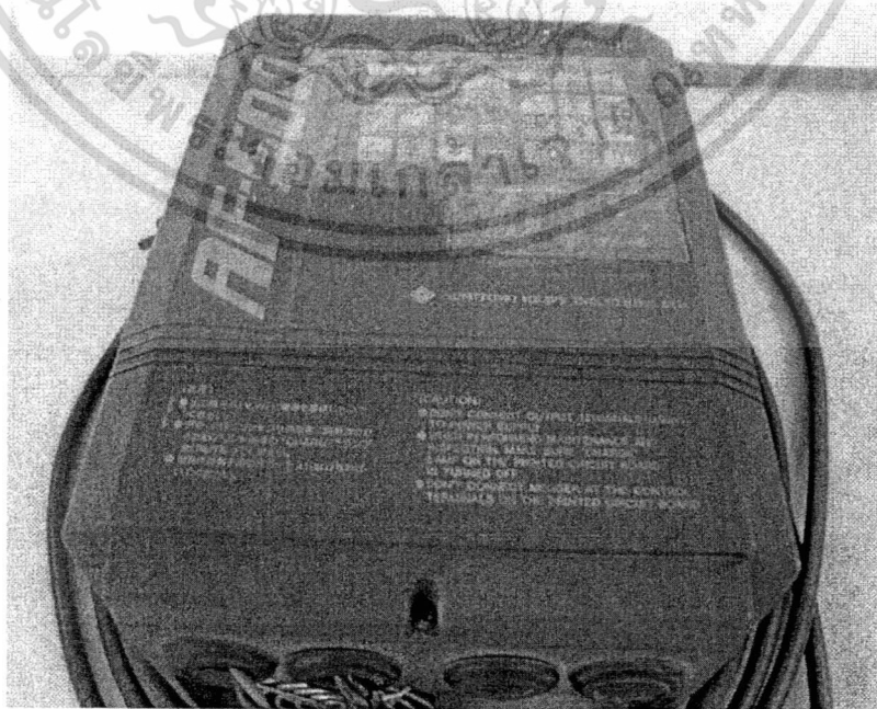
รูปที่ 3.15 อินเวอร์เตอร์ปรับความเร็วรอบมอเตอร์
