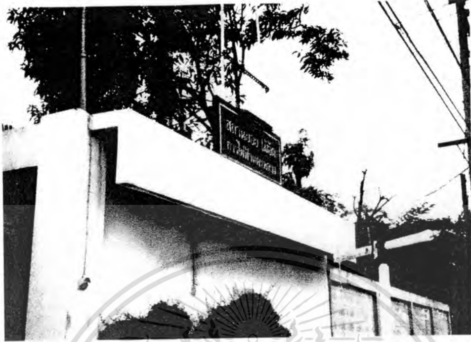
รูปที่ ข.39 แสดงจุดวัดที่ 39 สถานีไฟฟ้าบางนา ถนนสรรพคุณ
