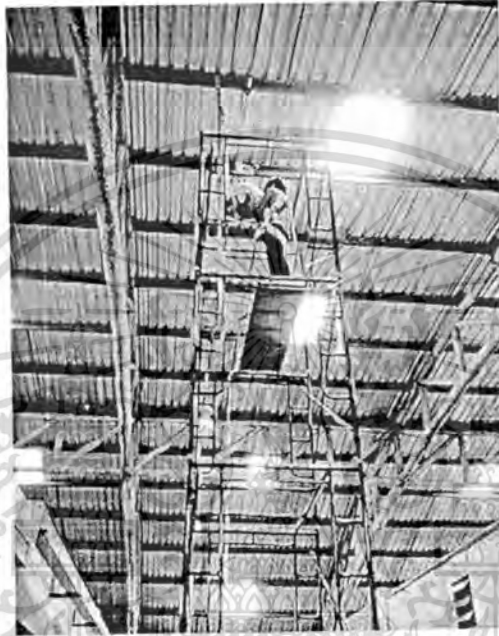
รูปที่ 5.1 การเปลี่ยนหลอดไฟในอาคารสูงซึ่งต้องใช้นั่งร้านตามกฎระเบียบความปลอดภัย
