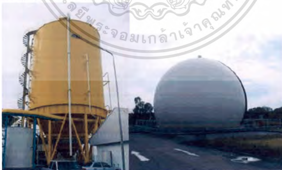
ภาพที่ 2.2 ถังย่อยสลายแบบไม่ใช้ออกซิเจน และถังเก็บก๊าซชีวภาพ โครงการผลิตปุ๋ยอินทรีย์และพลังงานจังหวัดระยอง เทศบาลนครระยอง
