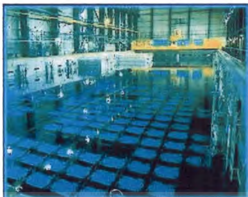
ภาพที่ 2.7 แสดงหลักการกำจัดกากจาก โรงไฟฟ้านิวเคลียร์เชื้อเพลิงจากเตาปฏิกรณ์นิวเคลียร์ จะถูกแช่น้ำในบ่อภายในโรงไฟฟ้า ไม่ต่ำกว่า 6 เดือน
