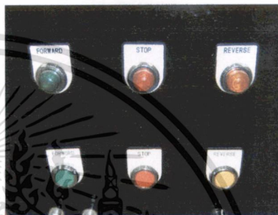
รูปที่ 3.7 สวิตช์สำหรับกลับขั้วไฟฟ้า พร้อมหลอดไฟแสดงสถานะ
