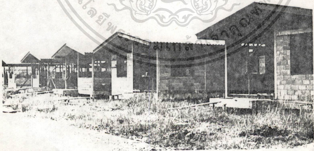
อาคารแบบที่ 1 อยู่ในระหว่างทำการก่อสร้าง
