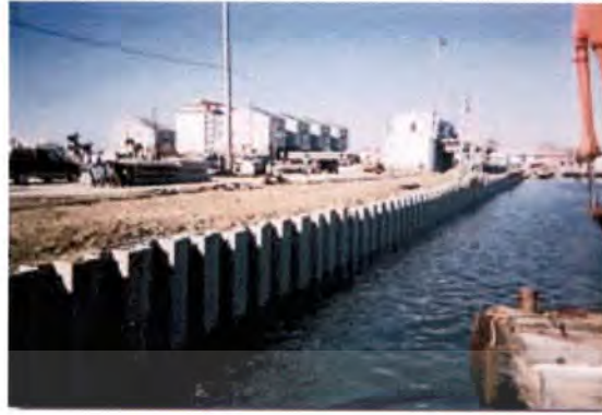
รูปที่ 5.13 การใช้ “PVC Seawall System” ที่ “Steampacket Place, Quay”
