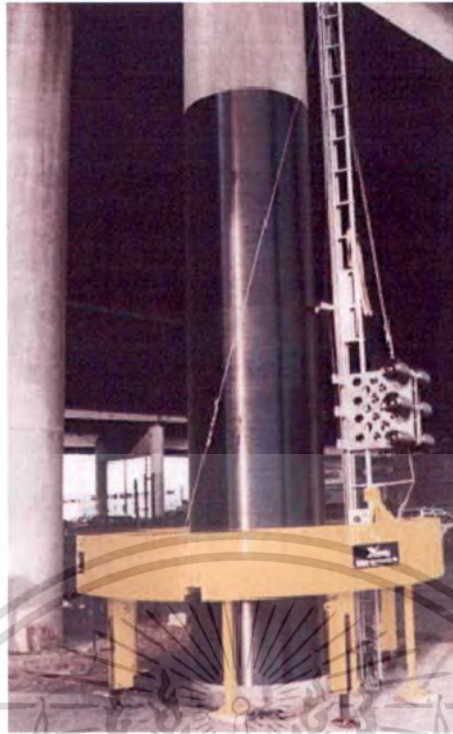
รูปที่ 5.20 แสดงลักษณะหลังการดำเนินการหุ้มผิวของเสาต่อม่อาคารขนาดใหญ่
