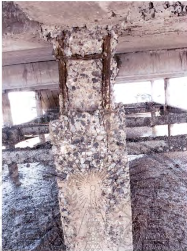
รูปที่ 4.33 ตอม่อสะพานปลาวัดโกมุทวัดนาราม 1
