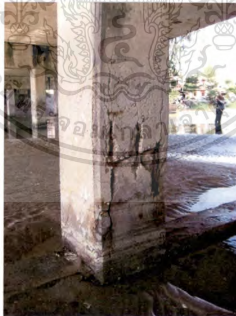
รูปที่ 4.16 เสาสะพานข้ามคลองวัดเจริญธรรม 4
