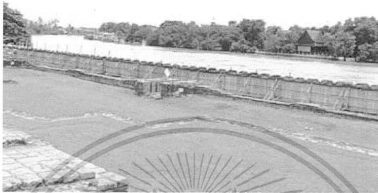
รูปที่ 2.19 การทำงานของพนังกั้นน้ำเมื่อระดับน้ำขึ้นสูง
