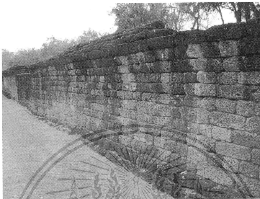
รูปที่ 3.13 กำแพงกั้นน้ำทำด้วยศิลาเรียงของวัดศรีสวาย ในอุทยานฯสุโขทัย
