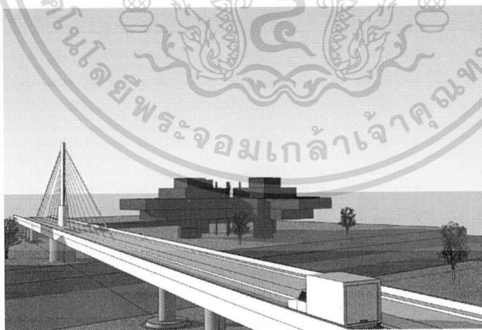
รูปที่ 6.8 สะพานชิงพาดช่วงประมาณ 110 เมตร
