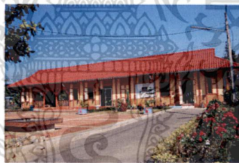
รูปที่ 2.26 อาคารสถานีรถไฟลำพูน อ.เมือง จ.ลำพูน
