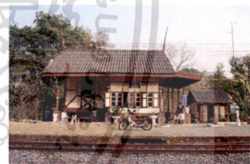
รูปที่ 2.27 อาคารสถานีรถไฟแม่ทะ อ.แม่ทะ จ.ลำปาง
