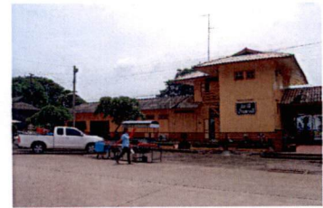
รูปที่ 2.13 อาคารสถานีบ้านตาคี อ.ตาคี จ.นครสวรรค์
