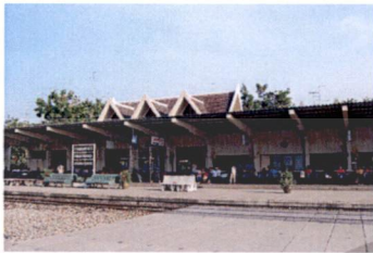
รูปที่ 2.31 อาคารสถานีนครปฐม อ.เมือง จ.นครปฐม
