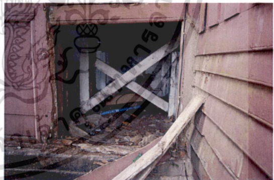
รูปที่ 4.32 ผนังด้านนอกตรงบันไดชั้นล่างอาคารทางทิศเหนือ
