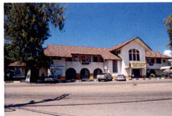
รูปที่ 2.12 อาคารสถานีอุตรดิตถ์หลังที่ 2 อ.เมือง จ.อุตรดิตถ์
