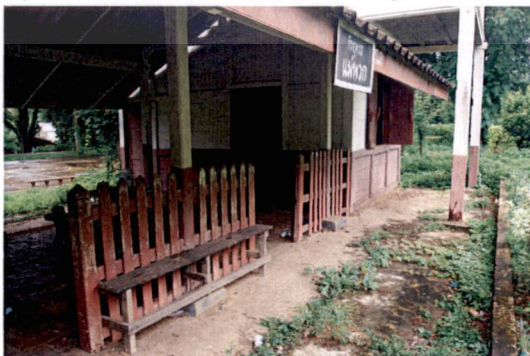
รูปที่ 4.33 รั้วไม้บริเวณโรงพักคอกยืม
