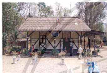
รูปที่ 2.5 อาคารสถานีปางป๋วย อ.แม่เมะ จ.ลำปาง
