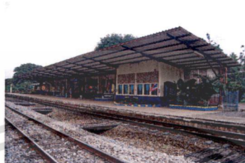
รูปที่ 2.41 อาคารสถานีท่าอ อ.เมือง จ.พิจิตร
