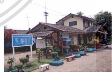
รูปที่ 2.30 อาคารสถานีรถไฟปากท่อ อ.ปากท่อ จ.ราชบุรี
