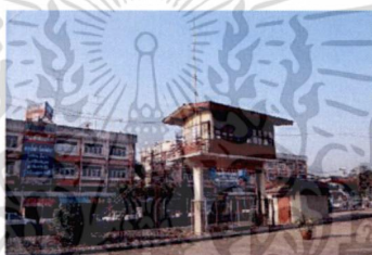
ภาพที่ 5.2 หอควบคุมอาณัติสัญญาณ สถานีรถไฟพนมเปญ
