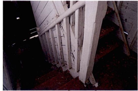
รูปที่ 4.9 บันไดขึ้นสู่ระเบียงชั้นบน
