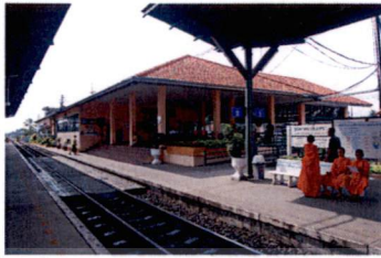
รูปที่ 2.20 อาคารสถานีชุมทางฉะเชิงเทรา อ.เมือง จ.ฉะเชิงเทรา
