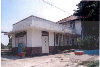
รูปที่ 2.40 อาคารสถานีวิจิตรวราจ อ.นครชัยศรี จ.นครปฐม
