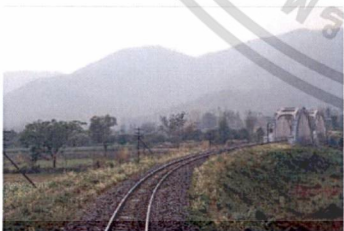
ภาพที่ 5.7 สะพานทางชมพู อำเภอแม่ทา จังหวัดลำพูน
