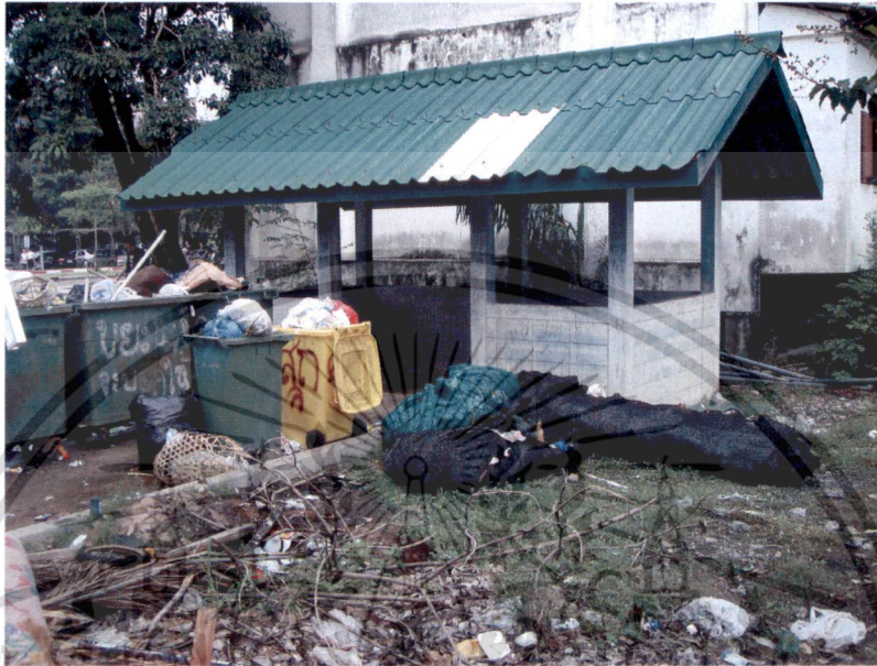
นี่คือสภาพโรงเรียนก่อนการปรับปรุง
