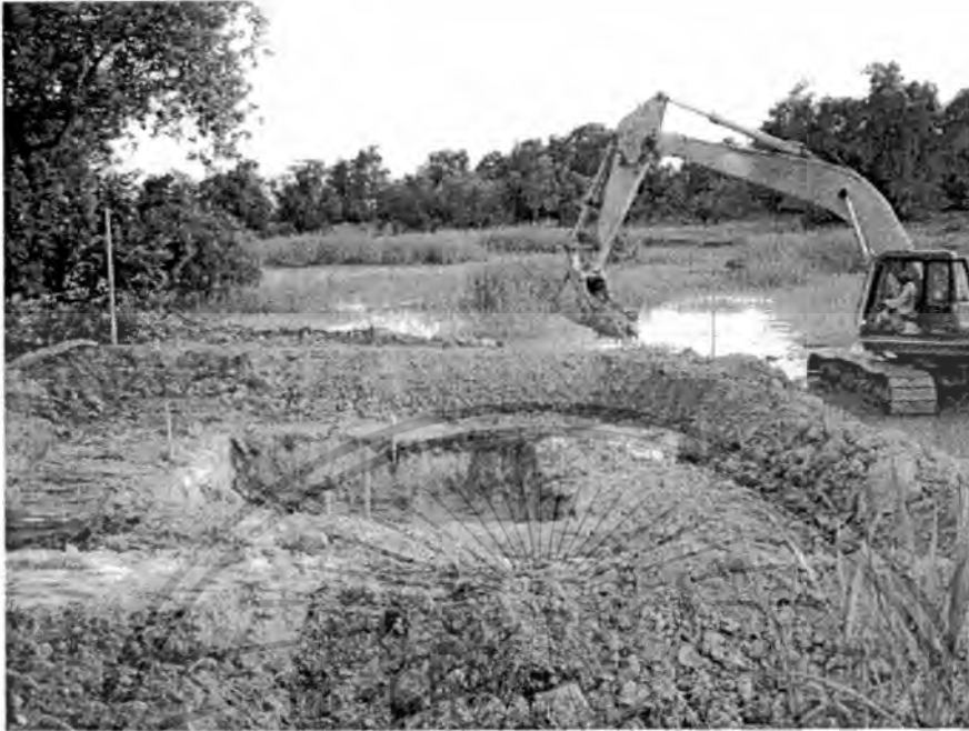
รูปที่ 6.3. แสดงภาพถ่ายขณะก่อสร้างบ่อเติมน้ำ
