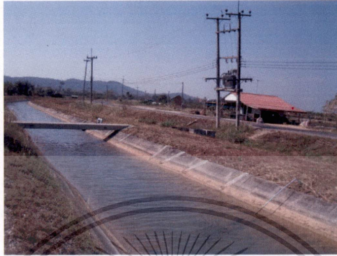
ภาพที่ 2 ระบบชลประทานน้ำเค็มเพื่อการเพาะเลี้ยงกุ้งทะเลในบริเวณโครงการ
