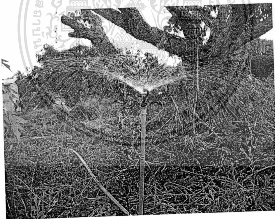
รูปที่ 33 แสดงการกระจายของหัวจ่ายรดน้ำเมื่อเปิดวาล์วใน zone C
