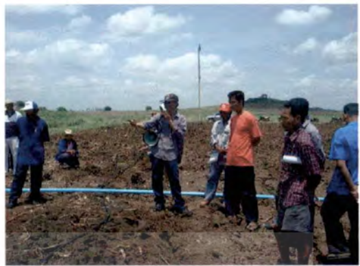
แสดงการติดตั้งท่อระบบน้ำ
