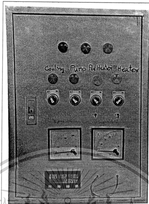
ภาพที่ ค.3 ตู้ควบคุมระบบไฟฟ้าของอุปกรณ์ทดลอง
