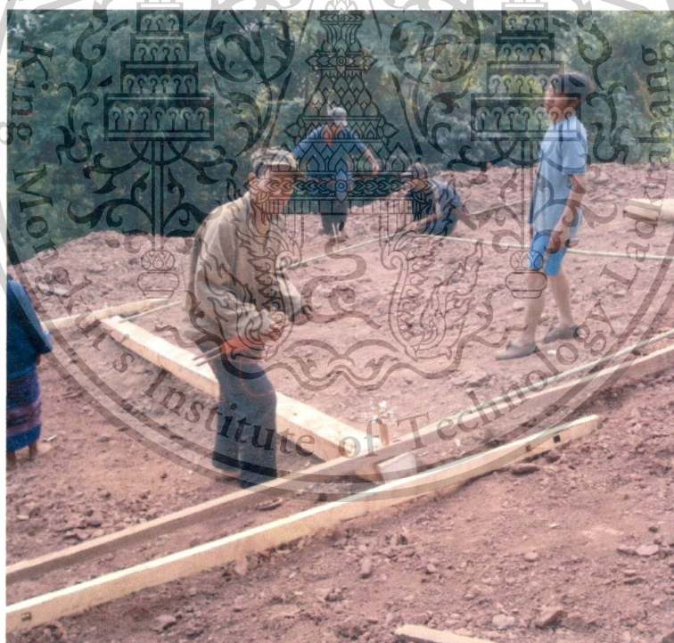
ภาพที่ 3.27 แสดงการใช้เชือกวัดขนาดขณะสร้างเรือนใหม่ ที่มา : จากการสำรวจภาคสนามโดย สัญชัย สุพิพัฒน์มงคล
