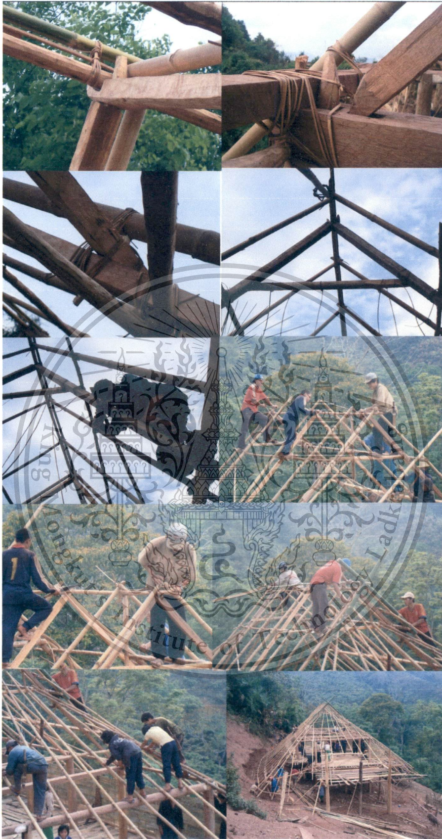
ภาพที่ 3.33แสดงรายละเอียดการทำโครงหลังคาเรือน
