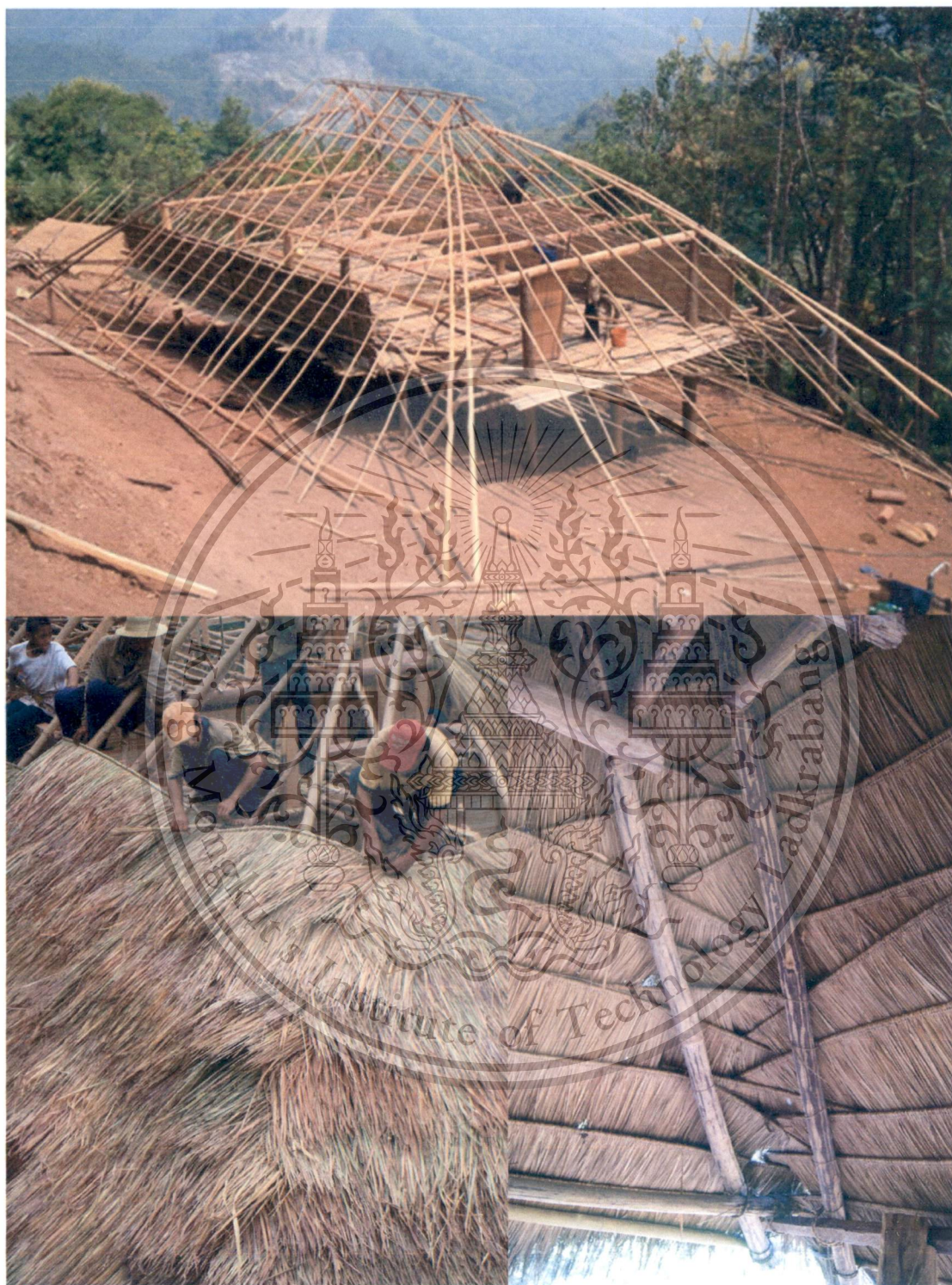
ภาพที่ 4.34 แสดงการมุงหลังคาบริเวณลำแคเรือนชาวปรีย บ้านปากำ ที่มา : จากการเก็บข้อมูลภาคสนามโดย สัญชัย สุพิพัฒน์มงคล
