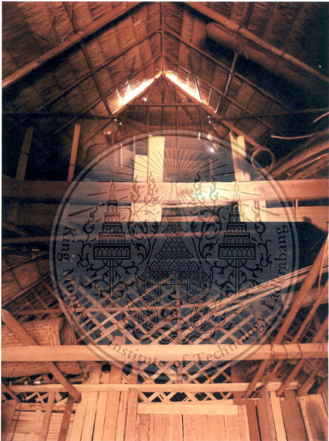
ภาพที่ 4.28 แสดงช่องเปิดระบายลมเหนือประตูภายในเรือนปรีย์ ที่มา : จากการสำรวจภาคสนาม โดย สัญชัย สุทธิพัฒน์มงคล
