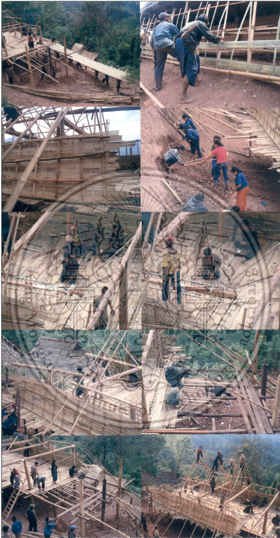
ภาพที่ 3.32 แสดงขั้นตอนการปูพื้นและกั้นผนังภายนอก
