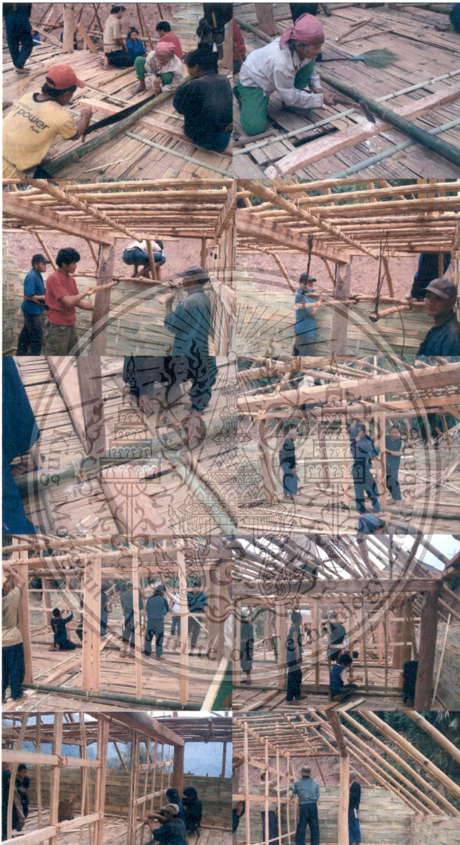
ภาพที่ 3.34แสดงขั้นตอนการกั้นผนังภายในเรือน
