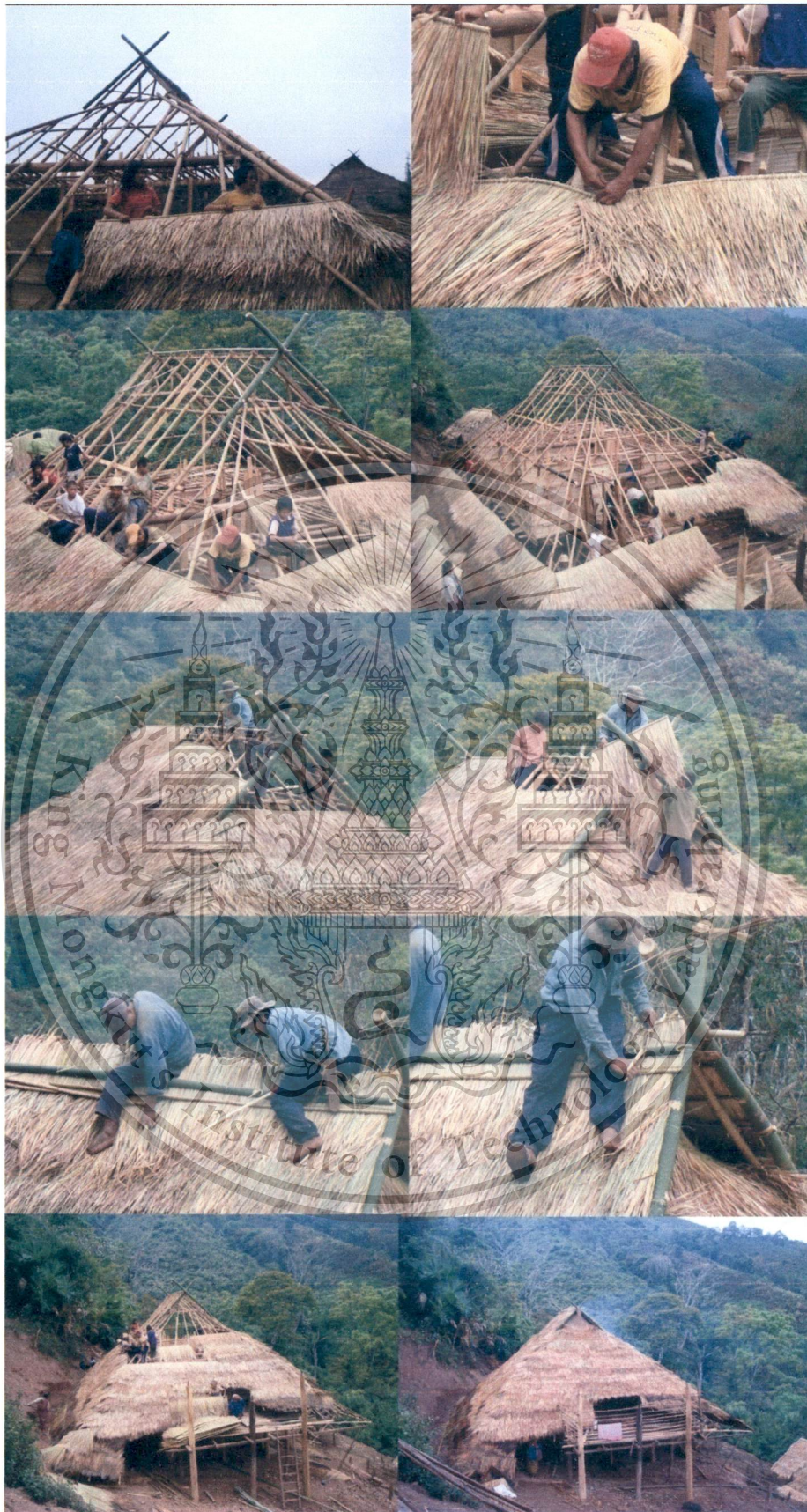
ภาพที่ 3.35แสดงขั้นตอนการมุงหลังคาเรือน
