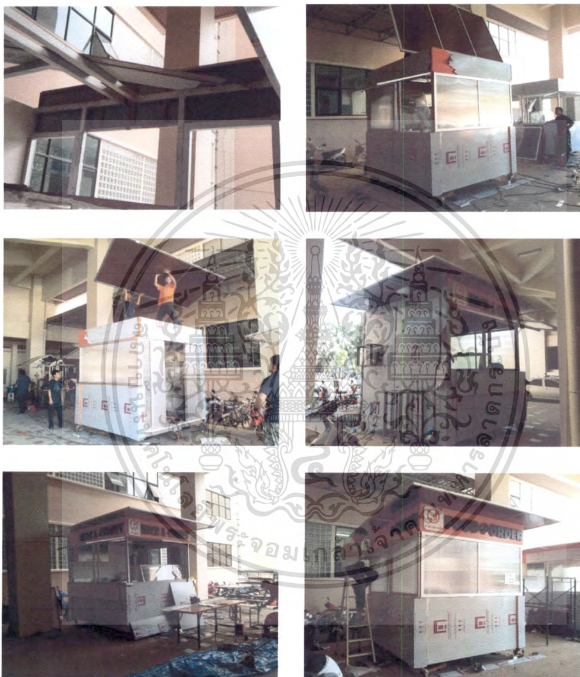
รูปที่ 7.6 แสดงการติดตั้งหลังคา
