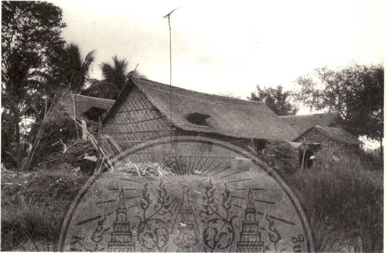
หับเผยบนหลังคาเจาะเพื่อยระนามหรือรับจากครัวและเป็นช่องให้แสงสว่างอีกแบบหนึ่ง สามารถปิดได้เมื่อต้องการ
