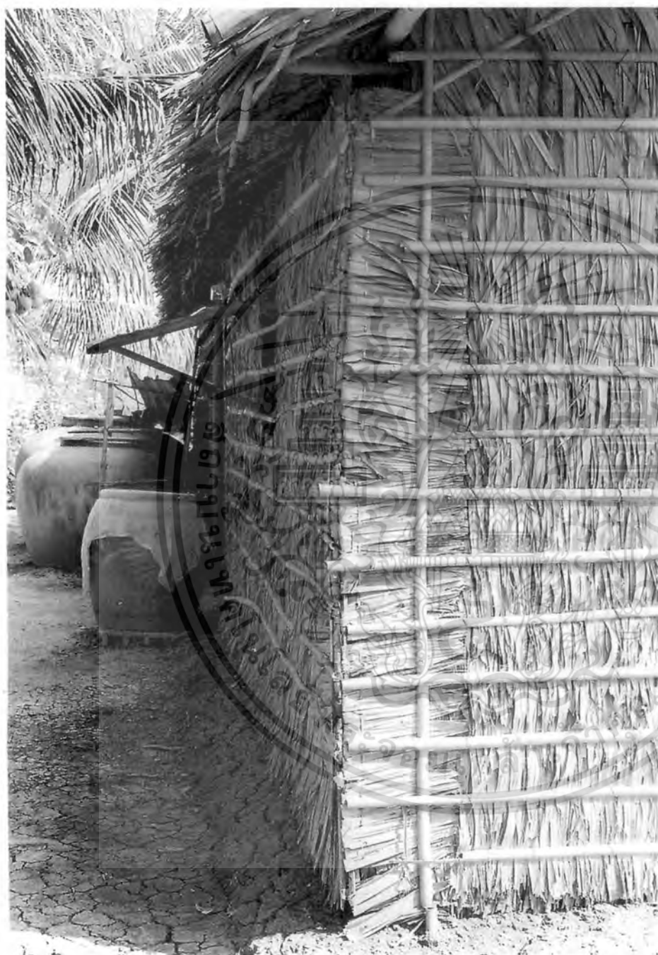
รายละเอียดของผนังกรจาก สังกศตบริเวณมูมเรือจะวางค้ำในแนวคั้งต่างกับส่วนของผนัง
