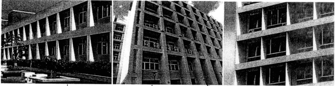
รูปที่ 4.2 รูปแบบแผงบังแดดที่ใช้โครงสร้างรับน้ำหนักเป็นแผงบังแดด
