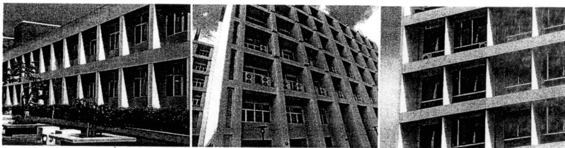
รูปที่ 4.2 รูปแบบแฟงบังแดดที่ใช้โครงสร้างรับน้ำหนักเป็นแฟงบังแดด
