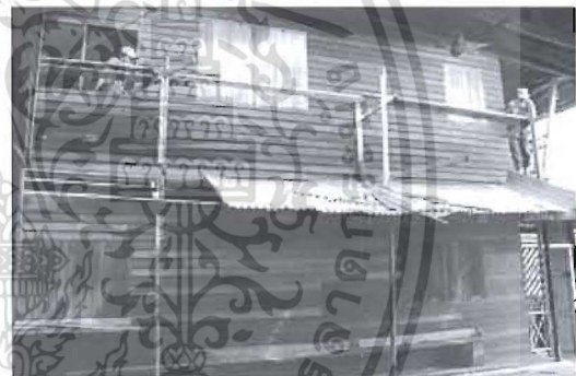
ภาพที่ 3.30 รั้วและติดตั้งผนังไม้ภายนอกใหม่ ประตูและหน้าต่าง ด้านทิศตะวันตก
